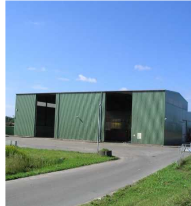
Anlieferung bei der Mechanisch-biologischen Abfallbehandlungs-anlage Wilsum (MBA)
