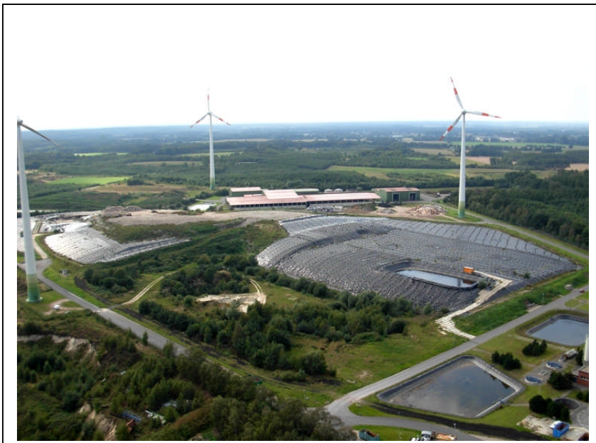
Bild 1: Deponie Wilsum II / Entsorgungszentrum Wilsum
